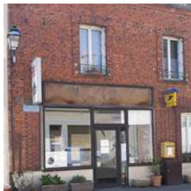
Relais Postal - SOUDAY Réouverture après travaux Courant 2026
